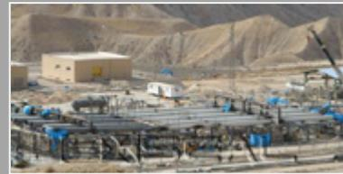
Erdgas ist bei der Gewinnung reich an Feuchtigkeit und daher hochkorrosiv. Durch den hohen Druck (in diesem Fall 250 bar) und eingesogene Gesteinspartikel entsteht ein immenser Strömungsabrieb an den Innenwänden des gesamten Rohrleitungsnetzes. Die Temperatur von etwa 60°C (umgebungsbedingte Temperatur des Gases) und die Aggressivität des Schwefelwasserstoffs verlangen zudem ein absolut hochwertiges und resistentes Beschichtungssystem für die Innenbeschichtung der Gasförderungsanlage.
