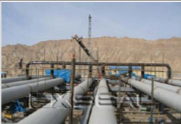
Bei "Tange Bijar" kommt ein multi-pipe Slug Catcher (Finger-Typ) zum Einsatz. Das Förder-Gasrohr wird in parallele Pipelines mit jeweils 56 inch (1,42 m) Durchmesser und 80 m Länge erweitert. In diesen "Fingern" expandiert das Gas und verlangsamt seine Strömungsgeschwindigkeit. Partikel und Feuchtigkeit setzen sich durch die leichte Neigung der Rohre in speziellen Fangvorrichtungen ab und können separat entfernt werden.
