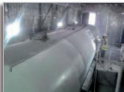
Die stark beschädigte und korrodierte Oberfläche wurde durch Strahlreinigung entsprechend vorbereitet und anfällige sowie schadhafte Stellen mit unserem Reparaturspachtel **Proguard GS** ausgebessert.
