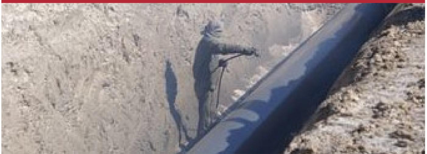
Die Pipeline weist einen Durchmesser von 24 inch auf. Bisher wurden 10 km neu beschichtet.
