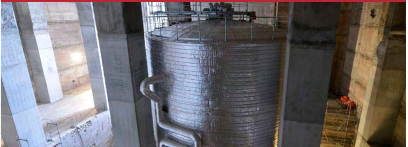
Die Ceramic Polymer GmbH ist mit dem Premium-System Proguard CN 200 an diesem einzigartigen Großprojekt beteiligt. Der gigantische Wärmespeicher im Inneren des Flakbunkers weist einen Durchmesser von 11,5 Metern sowie eine Höhe von 20 Metern auf. 2 Millionen Liter Wasser können gelagert und bis auf 90°C erhitzt werden.
