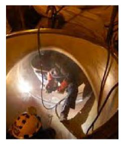
Das Förder-Gasrohr verzweigt in 12 parallel angeordnete Pipelines mit jeweils 48 inch (1,22 m) Durchmesser und 60 m Länge. In diesen "Fingern" expandiert das Gas und verlangsamt seine Strömungsgeschwindigkeit. Schmutzpartikel und Feuchtigkeit setzen sich durch die leichte Neigung der Rohre in speziellen Eintritts- und Austrittssammlern ab und können separat entfernt werden.
