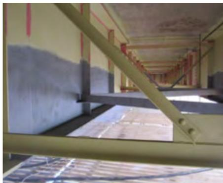
Im RAL-Farbtone „sandgelb“ wurde unsere Beschichtung Proguard 96 mit einer Schichtstärke von 200 µm im Airless-Spritzverfahren auf den Untergrund appliziert. Eine Schicht genügt, um eine hervorragende Korrosionsbeständigkeit zu bieten.
