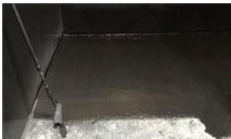
Beton- und Stahlstrukturen von Faultürmen, Jauchegruben, Güllebehältern, Gärfuttersilos, Biogasfermentern, Kompostieranlagen sowie abwassertechnischen Anlagen werden stetig einem hohen chemischen Angriff durch den Säuregehalt der Lagermedien ausgesetzt. Betonabtragungen von 1-2 cm pro Jahr und fatale Korrosionsschäden an Stahlkomponenten werden hier gemessen.
