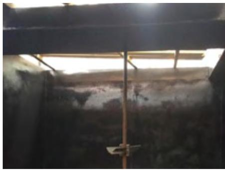
Die Betonwände und -decken wurden direkt mit Proguard CN-1M beschichtet. Bei der Applikation im Airless-Spritzverfahren ist eine Grundierung der Betonuntergründe nicht notwendig. Für die ersten Schichten wurde das Produkt in hellgrau mit einer Stärke von 400 µm im appliziert. Nach einer Wartezeit von 3,5 Stunden konnten die 2. Schichten in schwarz mit gleicher Stärke aufgetragen werden.
