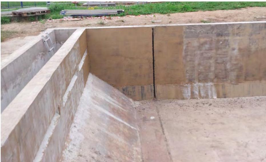
Sanierte Beckenkronne, Applikation der Grundierung
