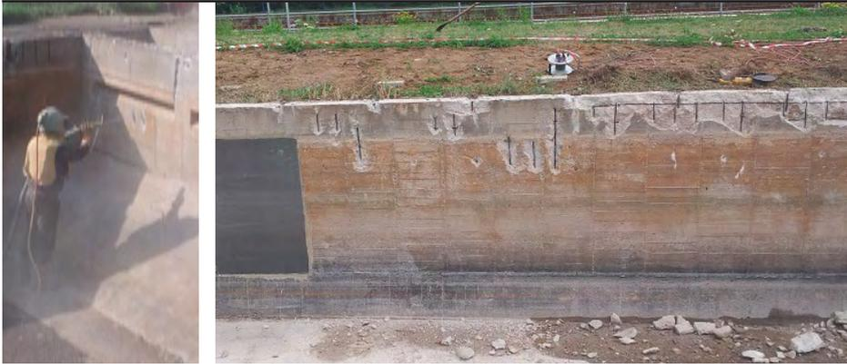
Sandgestrahlte Fläche, loser Beton bröckelte ab
