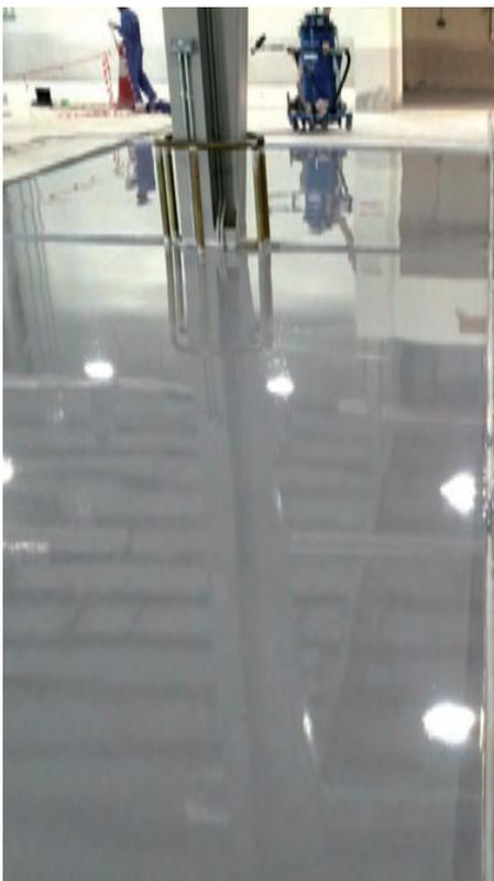
Neben Motoröl- und Kraftstoffresten wird der Boden im Waschbereich ständiger Nässe und sauren Waschzusätzen ausgesetzt. Für diesen Anwendungsbereich ist eine exzellente Chemikalienbeständigkeit der Beschichtung unerlässlich. Zudem muss aufgrund der hohen Punkt- und Flächenbelastung in der KFZ-Werkstatt eine außerordentlich hohe Druck- und Abriebfestigkeit gegeben sein. Im Vergleich zu Standard-Systemen erreichen die Ceramic Polymer-Bodenbeschichtungen eine wesentlich höhere Lebensdauer.
