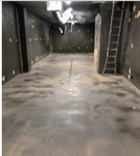
Der Betonuntergrund wird zunächst mit unserem Primer **CP-SYNTHOFLOOR 8010** grundiert. In die nasse Schicht wird Quarzsand gestreut, welches nach der Aushärtung ein Verankerungsprofil für die folgende Schicht bildet. Bodenunebenheiten werden durch eine zusätzliche Kratzspachtelung (Grundierung mit Quarzsand angereichert) ausgeglichen.
