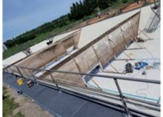
Die Gehwege und Treppen wurden ebenfalls saniert. Die Grundierung ARC 797(E) haftet auch auf feuchten Betonuntergründen, dringt tief ein und ermöglicht so eine effektive Versiegelung. Um eine abriebbeständige und auch sichere Oberfläche zu generieren, wird unsere Hochleistungsbeschichtung ARC 855(E) mit Silikonkarbid abgestreut.
