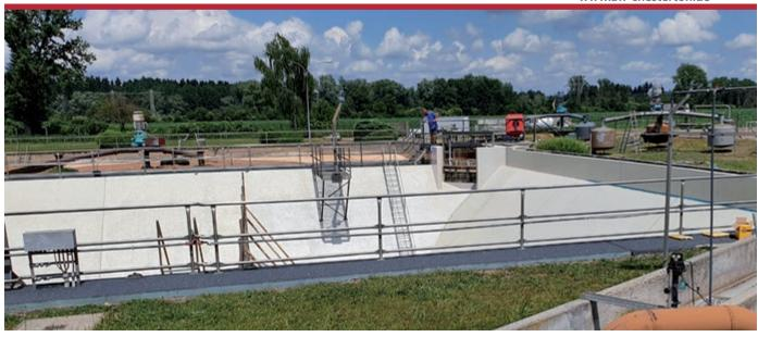
In der firmeneigenen Abwasseranlage eines süddeutschen Lebensmittelherstellers wurden 2 große Belebungsbecken mit hochwertigen ARC Beschichtungen saniert. Die Betonbehälter der 1970 erbauten Anlage wiesen starke Beschädigungen durch die Aggressivität des Abwassers auf; es war Zeit für eine umfangreiche Erneuerung. Des Weiteren wurden Gehwege und 2 Kreiselbelüfter restauriert und beschichtet.
