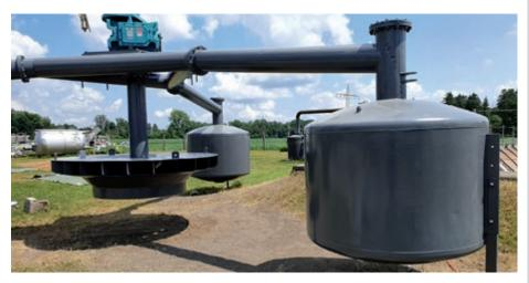
Kreiselbelüfter werden in den Belegungsbecken für die kontinuierliche Versorgung von Sauerstoff eingesetzt. Nach der langen Betriebsdauer zeigten diese fortgeschrittene Korrosionsschäden. Nach der Strahlreinigung werden die Metallkomponenten ebenfalls mit unserem resistenten System ARC 855(E) geschützt.
