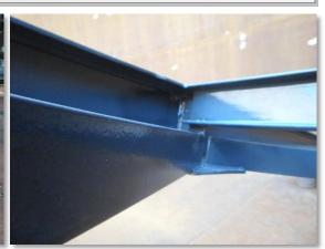
Балки несущих конструкций крыши были обработаны материалом Ceramic-Polymer SF/LF, нанесенным в 2 слоя толщиной 400 мкм каждый. Эта система не содержит растворителей и обеспечивает надежную и эффективную защиту от коррозии.
