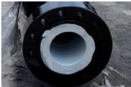
Nuestro producto de revestimiento PROGUARD CN 200 se aplicó en 2 capas, cada una con un espesor de 500 micras. El proceso se llevó a cabo con precisión con un equipo de recubrimiento interior de tuberías. Debido a la baja viscosidad de este sistema de recubrimiento, es pulverizable sin precalentamiento. El rápido tiempo de curado permitió terminar el trabajo en 24 horas!
