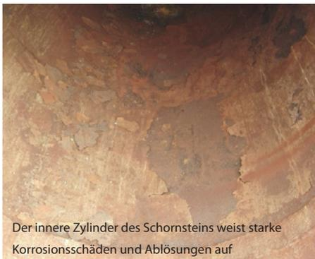
Der innere Zylinder des Schornsteins weist starke Korrosionsschäden und Ablösungen auf
