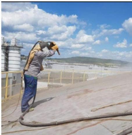
Поверхность крыши была подвергнута предварительной пескоструйной обработке до степени чистоты Sa2,5.
