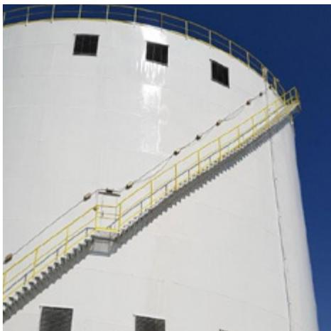
Восстановленный резервуар; долговременная защита от коррозионного воздействия промышленной атмосферы.
