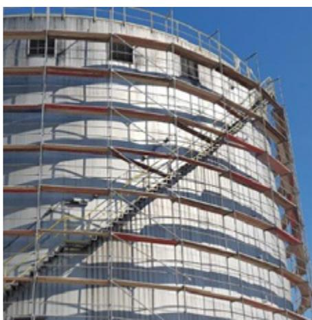
И грунтовку, и покрывающий слой тонким слоем наносили методом безвоздушного распыления.
