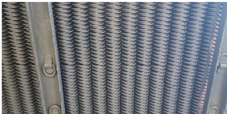
Después de inundar todos los bucles del enfriador, estarán protegidos contra la corrosión y depósitos de suciedad.
