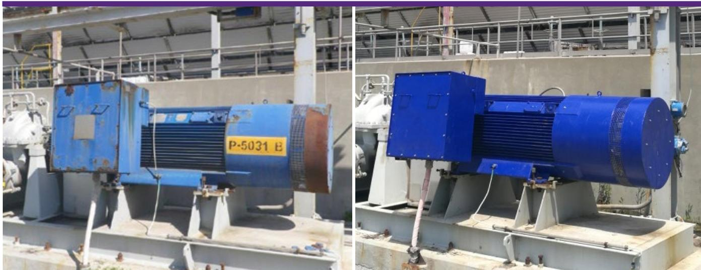
Im Polypropylen-Werk der „Hellenic Petroleum“/Thessaloniki wurde vor Kurzem ein Mittelspannungsmotor für die Kühlwasser-Umwälzpumpen restauriert. Der Motor ist seit dem Jahr 2000 im Einsatz und zeigte äußerst starke Erosionsschäden und Lochfraßkorrosion am Verdichtergehäuse und Anschlusskasten. Das Reparatursystem ARC 858(E) unseres Mutterkonzerns A. W. Chesterton sowie Ceramic-Polymer-Systeme ermöglichten eine effiziente Erneuerung und schnelle Wiederinbetriebnahme des Elektromotors (Typ ATEX).
