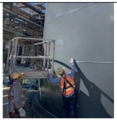
${\bf Externe\ Grundbeschichtung:\ CERAMIC-POLYMER\ STP-EP;}$ unsere Dünnfilmbeschichtung ermöglicht langfristigen Korrosionsschutz für extrem aggressive Umgebungen. Das Produkt stellt die optimale Basis für qualitative Deckbeschichtungen dar. Zum Schutz des Großtanks wurde eine Schicht von 200  $\mu m$  im Airless-Verfahren appliziert. Nach einer Aushärtungszeit von wenigen Stunden konnte die Fläche mit unserem Topcoat überbeschichtet werden.
