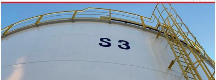
Süditalien / Sizilien: In einer Raffinerie wurde ein großformatiger Tank für Industriewasser mit Ceramic-Polymer Innen- und Außenbeschichtungen versehen. Der Kunde wählte bewusst unsere 1-Schicht-Markensysteme, da sie bei minimalen Applikationskosten einen umfassenden Korrosionsschutz ermöglichen. So wird der Tank für viele Jahre gegen korrosive Industriewässer und aggressive atmosphärische Einflüsse geschützt.
