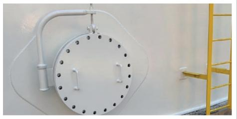
Externe Endbeschichtung: PROGUARD 169 (37) ist eine hochvernetzte 2-Komponenten Polyurethanbeschichtung. Unser Topcoat bietet Resistenzen gemäß ISO 12944-2, Korrosivitätskategorie C5. Daher ist es das ideale Produkt für anspruchsvolle Industrieumgebungen. PROGUARD 169 (37) ist erhältlich in RAL und NCS Farben, es kann in einer dünnen Schicht aufgetragen werden und zeigt eine schnelle Aushärtung. In diesem Fall wurde eine Schicht von 70 µm durch Airless-Spritzen appliziert.
