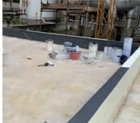
Der Schutz der Wände erfolgt in einem Schritt; unsere Deckbeschichtung PROGUARD CN-1M wird direkt appliziert.
