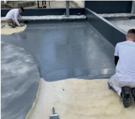
Auf dem Boden wird eine Zwischenschicht aufgetragen. CERAMIC-POLYMER STP-EP-HV bietet eine exzellente Haftung zum Substrat sowie hohe Resistenzen gegen Abrieb und Chemikalien.
