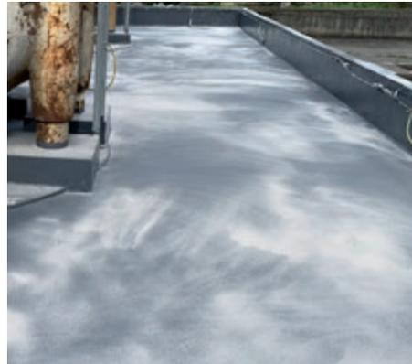
Um eine rutschhemmende Struktur zu erreichen, streut „Uniresine“ großzügig Quarzsand auf die noch feuchte Oberfläche. Überschüssiger Sand wird nach der Trocknung entfernt.
