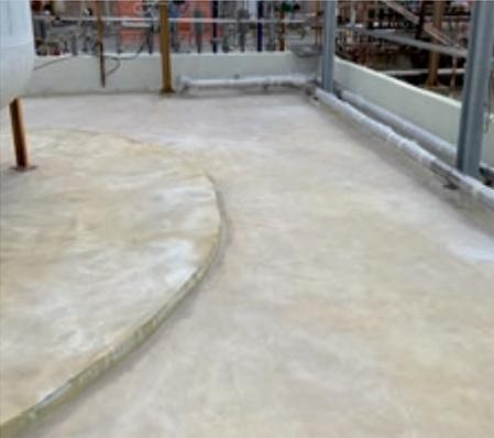
Der Betonuntergrund wird zunächst mit unserem CP-SYNTHOFLOOR 8010 unter Anreicherung von Quarzsand grundiert.
