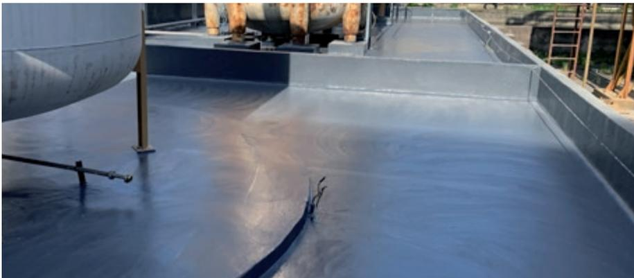
Als Deckbeschichtung kommt nun PROGUARD CN-1M zum Einsatz. Dieses Hochleistungsprodukt ist speziell für äußerst aggressive Umgebungen konzipiert, es bietet erstklassige Chemikalienfestigkeit und Abrasionswiderstand – ein Garant für den dauerhaften Werterhalt der Tanktassen.
