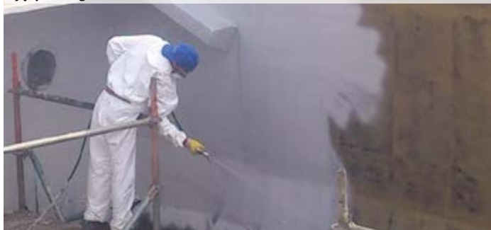
► Odnowienie zbiornika buforowego w oczyszczalni ścieków – dostępne w języku angielskim
