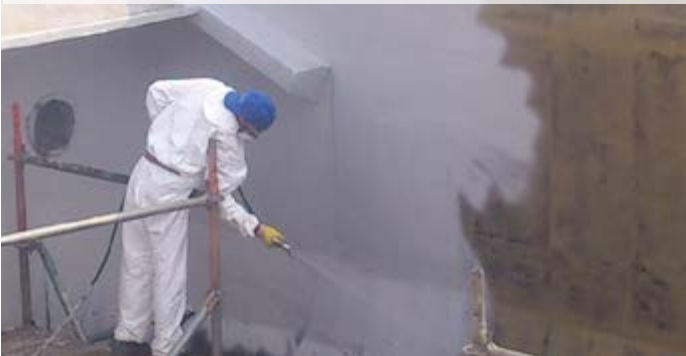
► Sanierung von Betonwänden eines Kläranlagen-Pufferbeckens
