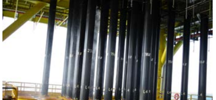
► Außenbeschichtung von Steigleitungen und Pipelines für Ölplattformen in China
