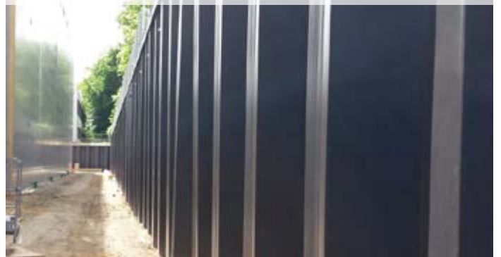
► Außenbeschichtung von 1.800 m² Spundwand-Konstruktion
