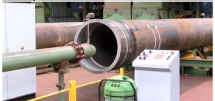
► Innenbeschichtung von Kühlwassersteigleitungen für umfangreiches FLNG-Projekt in Australien
