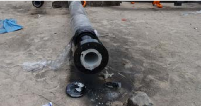
► Innenbeschichtung von Steigleitungen für heißes Rohöl (80 °C)
