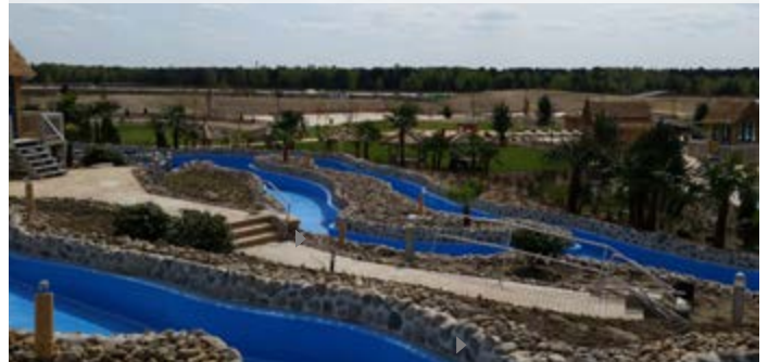
► UV-resistente Beschichtung für den längsten Wildwasserkanal Deutschlands im „Tropical Islands“
