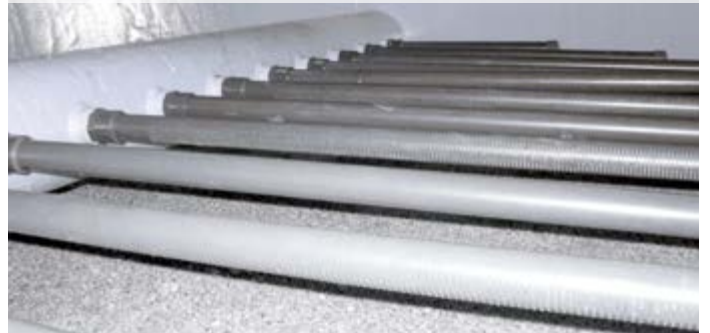
► Sanierung von Schwimmbadfilter ermöglicht Reduzierung des Frischwasserbedarfs um fast 50 %
