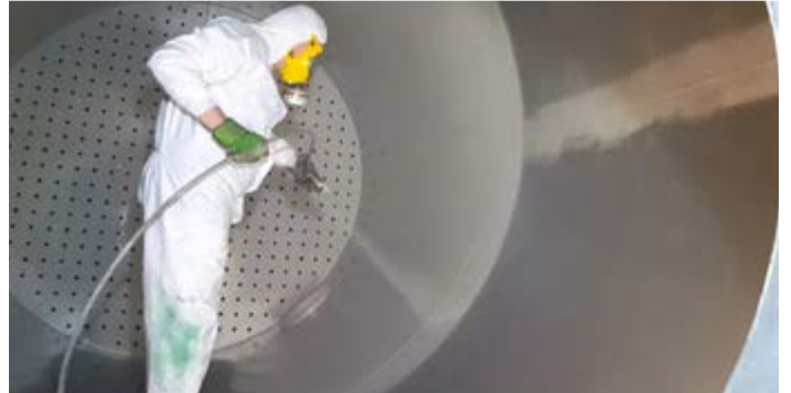
► Innenbeschichtung von Kies- und Aktivkohlefiltertanks
