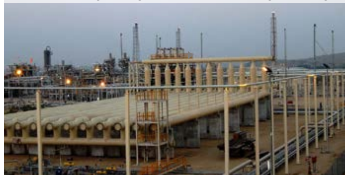
► Innenbeschichtung von Slug-Catcher-Rohren für die Erdgasförderung
