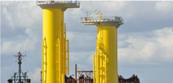
► Unsere Offshore-Beschichtungen sichern die Funktionalität von Windenergieanlagen
