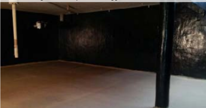
► Beschichtung von Betonspeicher für aggressiv wirkende Bioabfälle
