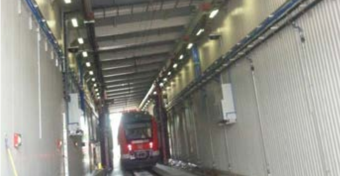
► Beschichtung von DB-Waschanlage – Resistenz gegen saure Waschlösung
