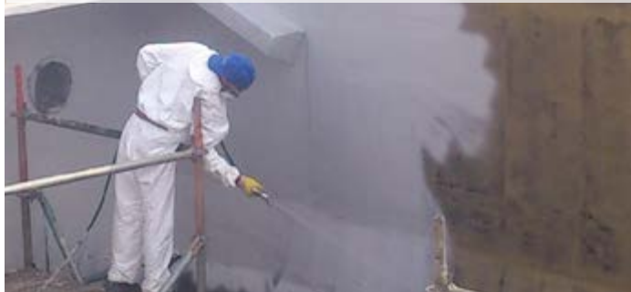
► Rehabilitación de un tanque del almacenamiento intermedio en una planta de aguas residuales con sistemas de protección de hormigón
