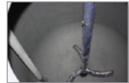
erneuerte Beschichtung mit Proguard VEG
