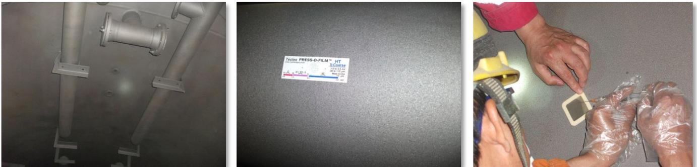
Der Tank wurde zunächst mittels Hochdruckwasserstrahl gereinigt und von jeglichen Verschmutzungen befreit, anschließend gemäß dem Standard SSPC-SP10 gestrahlt. Die Oberfläche wurde visuell inspiziert; sie zeigte ein Rauigkeitsprofil von 50-100 µm. Weitere Tests zur Untersuchung des Restsalzgehalts wurden entsprechend der Bresle-Methode durchgeführt. Sie entsprachen den Prüfanforderungen, es war keine erneute Reinigung des Innenraums nötig.
