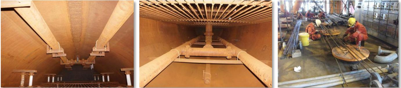
Der Dehydrator war vor dem Strahl- und Beschichtungsvorgang bereits stark korrodiert. Innenliegende Komponenten wie Elektroden und Rohrleitungen wurden demontiert und separat behandelt.
