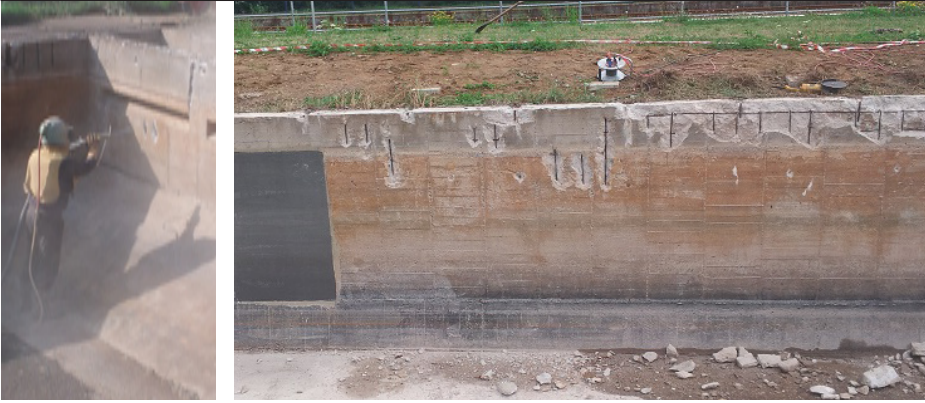
Área chorreada, se eliminó el hormigón suelto
