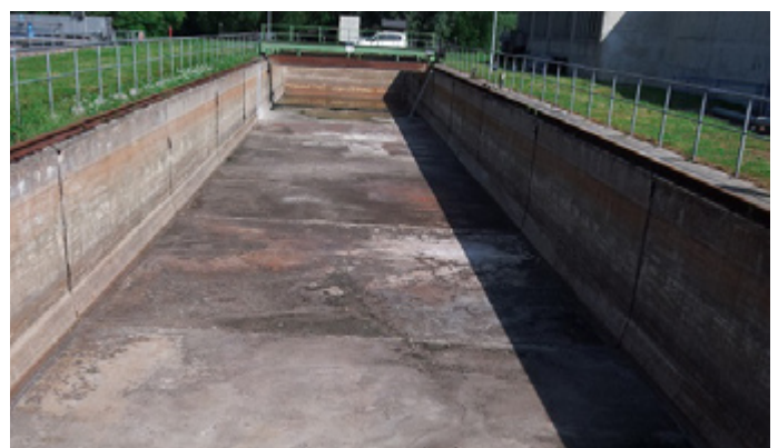
Tanque de almacenamiento antes de la rehabilitación
