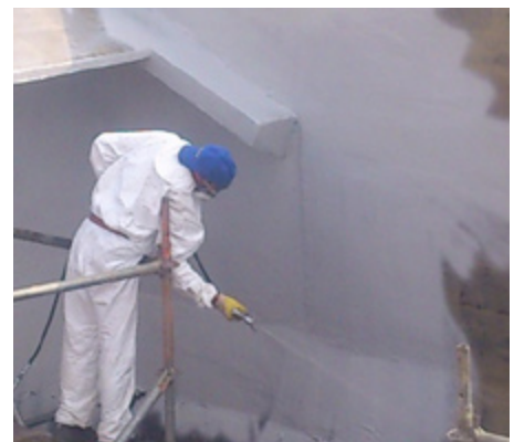
Aplicación del recubrimiento PROGUARD CN 200
