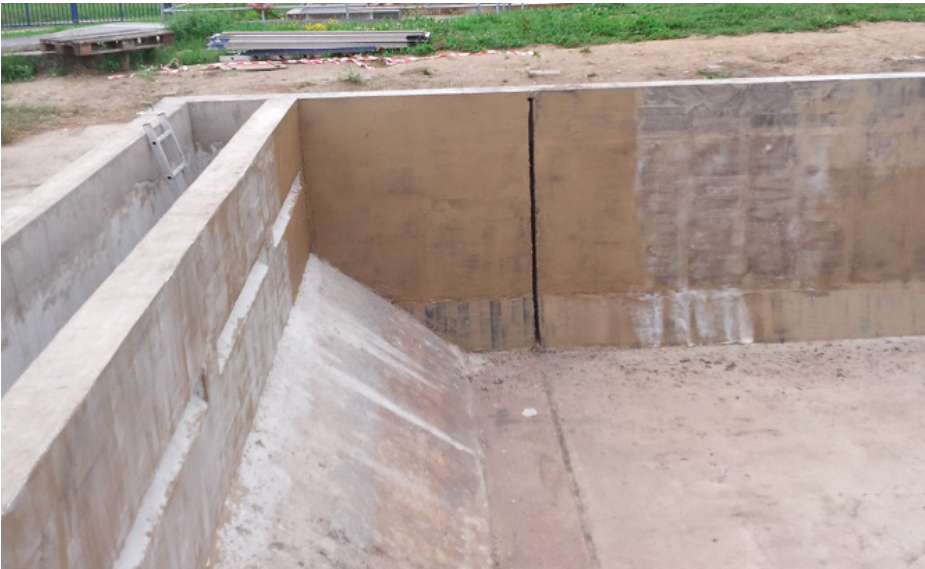
Reconstrucción del borde superior, aplicación de la imprimación
