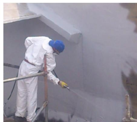
Нанесение покрытия PROGUARD CN 200
