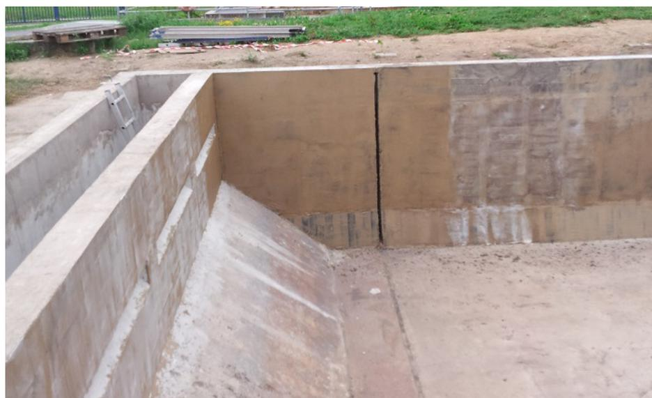
Отремонтированная верхняя часть бассейна, нанесение грунтовки
