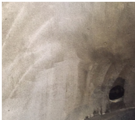
Грунтованная поверхность стен, подвергнутая струйной обработке кварцевым песком
