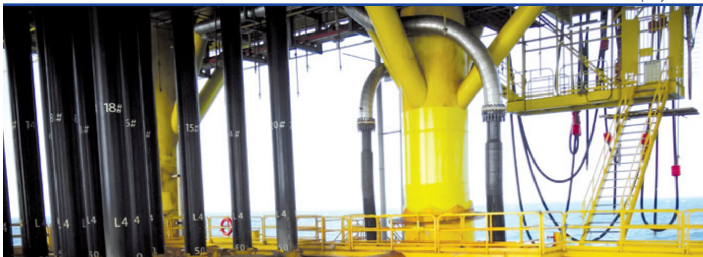
Напорные трубопроводы (черного цвета) после 10-месячной эксплуатации
