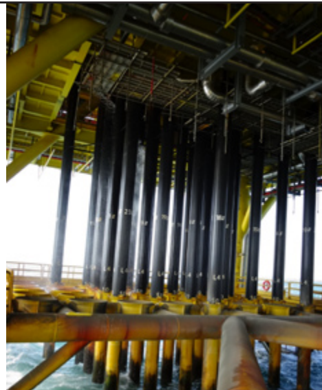
Напорные трубопроводы (черного цвета) после 10-месячной эксплуатации
