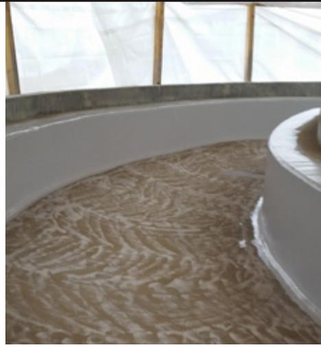
Después de curada la imprimación, la superficie fue lijada y se aplicó el producto de recubrimiento PROGUARD CN 200.
