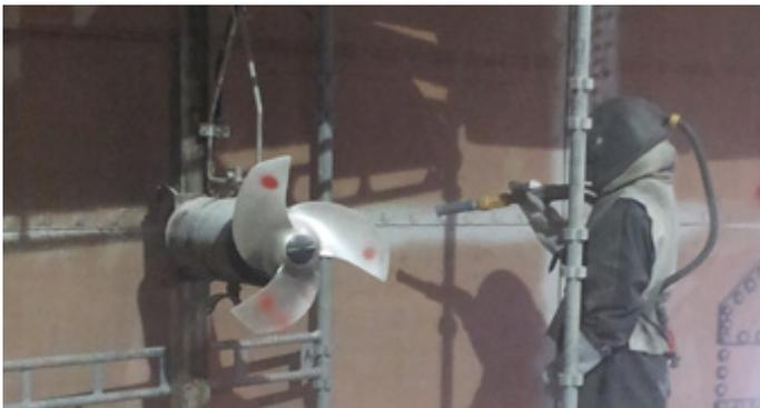
Вначале поверхности подверглись пескоструйной обработке.
