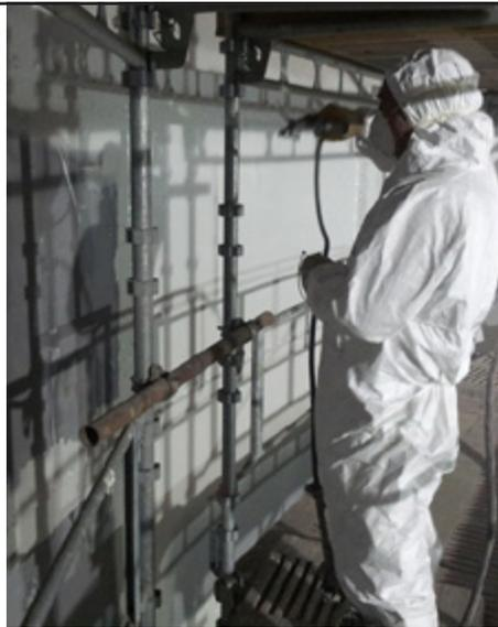
Нанесение покрытия PROGUARD CN 200 методом безвоздушного распыления.
