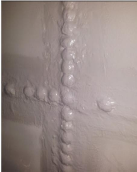
Обработка швов и заклепок материалом PROGUARD CN 200.
