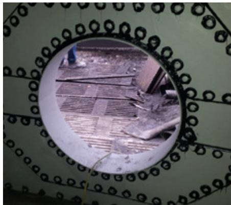
Дополнительная гибкая затирка заклепок, швов и кромок стыков.
