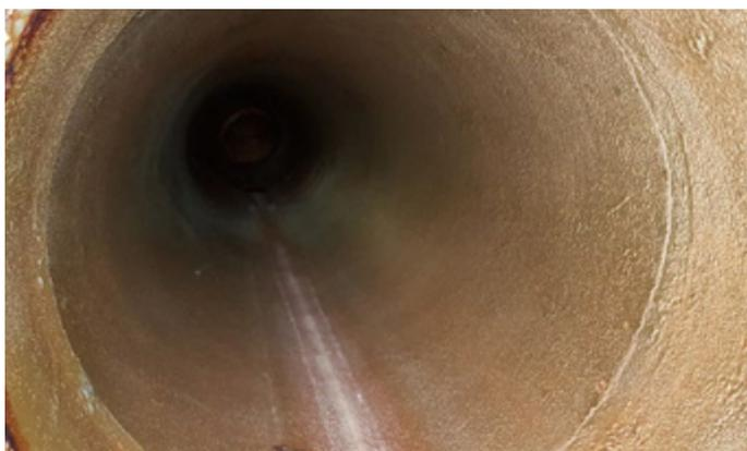
Tubería de presión principales (diámetro y 700 mm), Recubrimiento interno después de 10 años de operación –derechos de imagen: Bremenports & de GmbH Co KG
