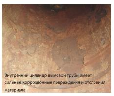
В процессе сжигания отходов образуются агрессивные газы, вредное воздействие которых снижают абсорбционной обработкой влажным методом. Однако даже после комплексной десульфатации, несмотря на соответствие строгим требованиям по предельным значениям вредных выбросов в атмосферу, в очищенных дымовых газах, разогретых до высокой температуры, еще присутствуют такие компоненты, как диоксид серы, хлорид водорода, диоксид азота и окись углерода.
