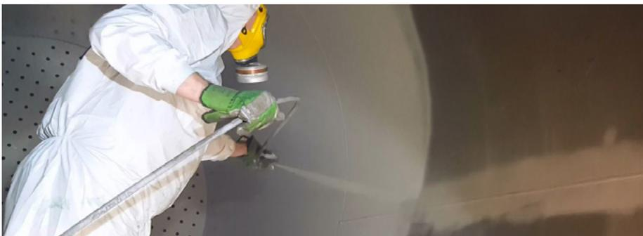
Aplicación muy sencilla de PROGUARD 200 CN a pistola . En esta foto se puede ver que las soldaduras fueron previamente tratadas con el mismo PROGUARD CN 200 en los trabajos preparatorios mediante brocha.
