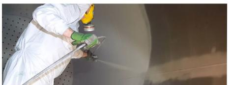
Простота нанесения материала PROGUARD CN 200 с помощью метода безвоздушного распыления. На фото видно, как во время подготовительных работ осуществляется обработка сварных швов продуктом покрытия.
