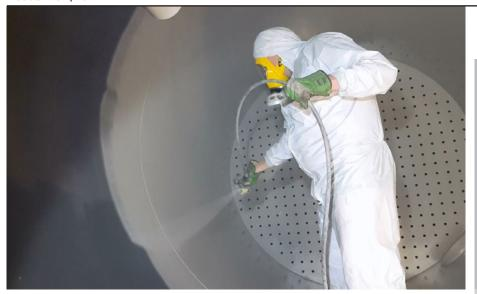
Наряду с выдающимися физическими свойствами, наша система покрытия PROGUARD CN 200, не содержащая растворителей, отличается простотой переработки с помощью метода безвоздушного распыления.
