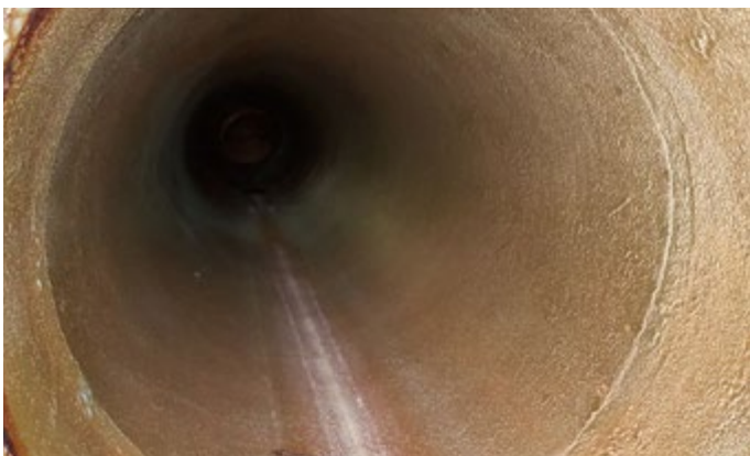
Großes Druckrohr (Durchmesser ND 700 mm), Innenbeschichtung, nach 10-jährigem Betrieb - Bildrechte: bremenports GmbH & Co. KG
