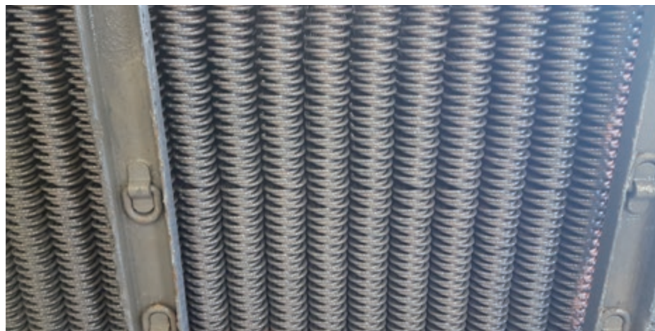
Nach der Flutung sind alle Schlingen des Kühlers langfristig vor Korrosion und Schmutzablagerungen geschützt. Die Applikation eignet sich nicht nur für neue Komponenten, sondern auch für reparierte Wärmetauscher.
