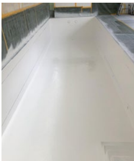
PROGUARD CN 200 in weiß als 2. Beschichtungsschicht ermöglicht eine hochwertige Optik des Pools.
