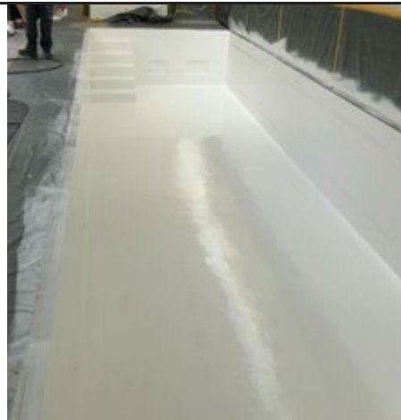
Erster Auftrag der Beschichtung PROGUARD CN 200 in hellgrau, appliziert im Airless-Spritzverfahren.
