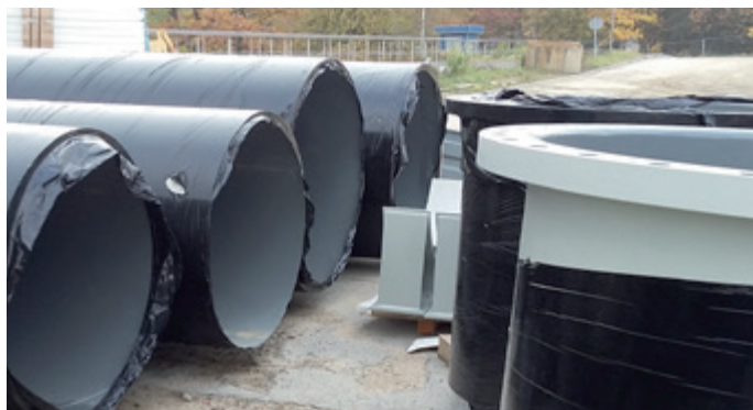
Beschichtete Rohre und Halterungen vor der Montage
