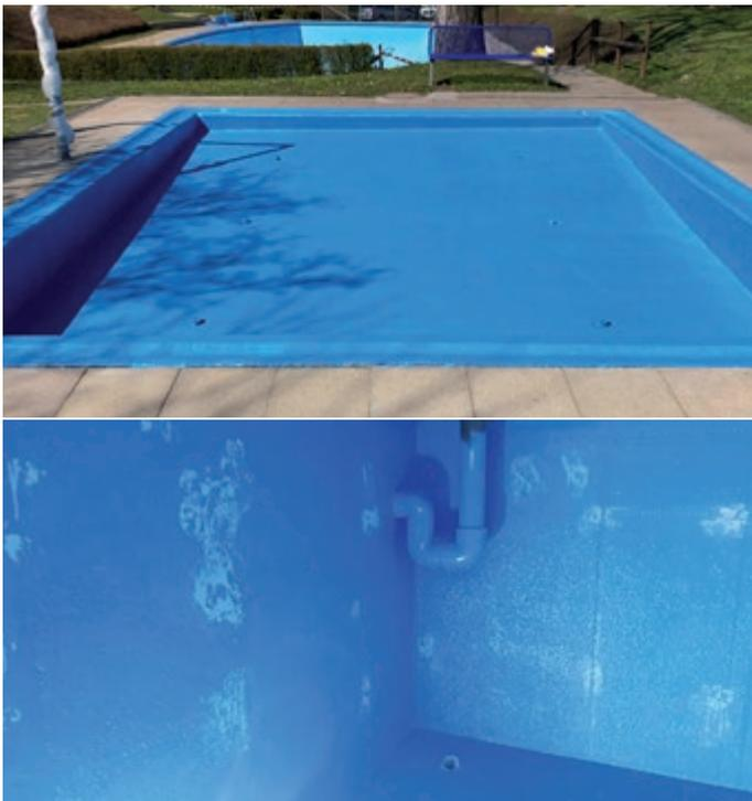
Beschichtungen, die in Schwimmbecken oder Lagerbehältern für Chlorwasser verwendet werden, müssen verschiedenartige Resistenzen aufweisen. Die Abdichtung zum Betonuntergrund ist genauso entscheidend für den dauerhaften Betrieb wie die Stabilität gegen Chlor. In Pools muss weiterhin eine gute Resistenz gegen UV-Strahlung und Abrieberscheinungen gegeben sein.
