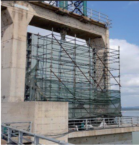
Beschichtetes Schleusentor, flussaufwärts
