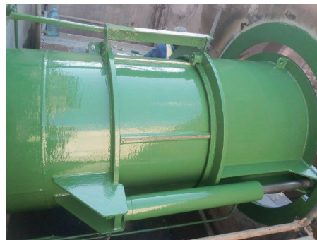
Beschichtete Außenhülle des Strahlventils
